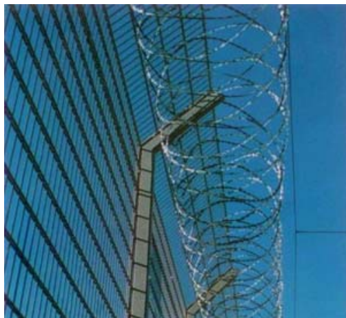
Рис. 1.10. - Комбинированное верхнее дополнительное ограждение.
